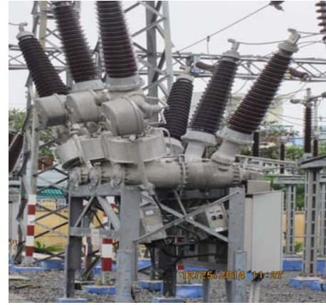
Hình 5: Mô hình và hình ảnh thiết bị compact 110kV đã được triển khai
