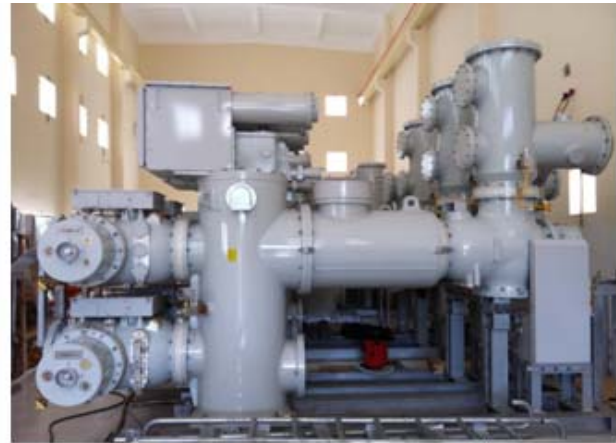
HTPP GIS 110kV đã thi công lắp đặt
