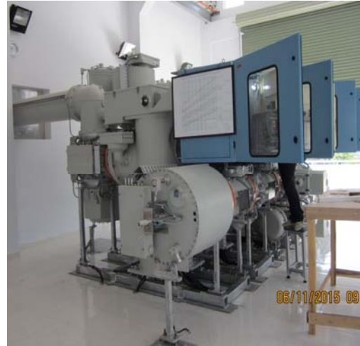
Hình 6: Mô hình và hình ảnh của thiết bị GIS 110kV đã được triển khai
